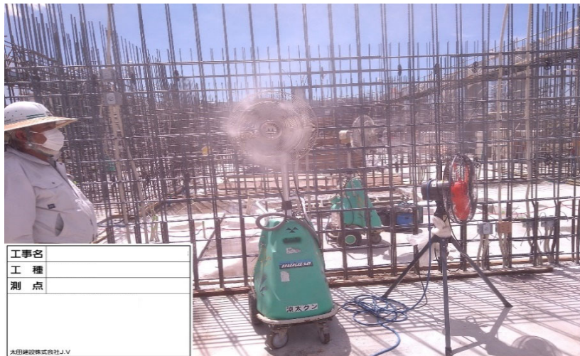
大型扇風機設置
