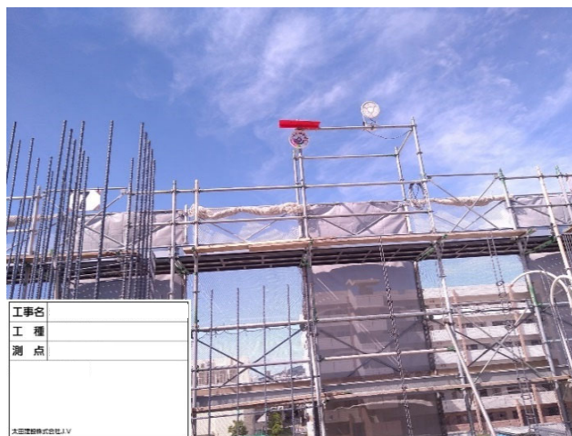
温度計現場設置
